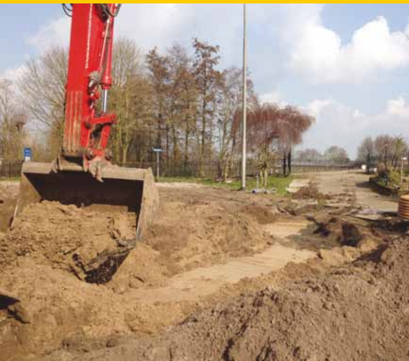
Het graven van een extra drainage.
