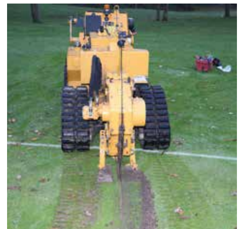
Bij de aanleg wordt zoveel mogelijk sleufloos gewerkt.
