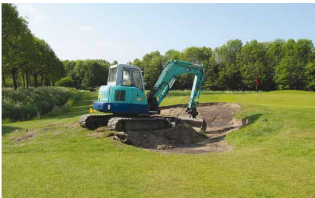
Na bepaling van de contouren de bunkers uitgraven met de minikraan.
