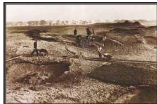
Aanleg van een bunker op Muirfield Golf Course.
