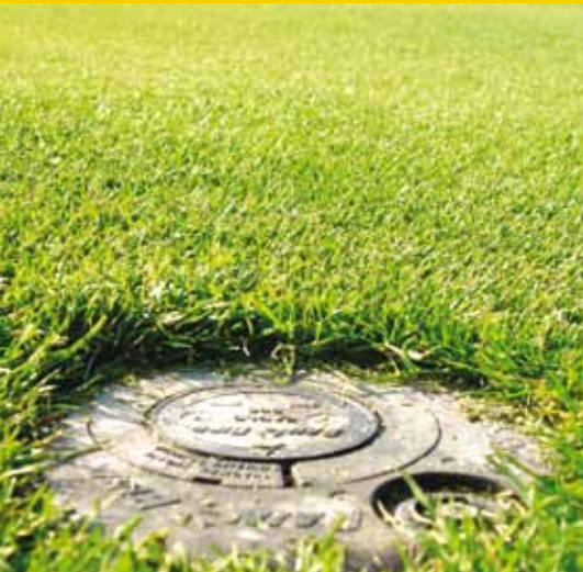
Foto nr. 3. We zien hier een sproeikop die net onder de oppervlakte van de fairway ligt.
