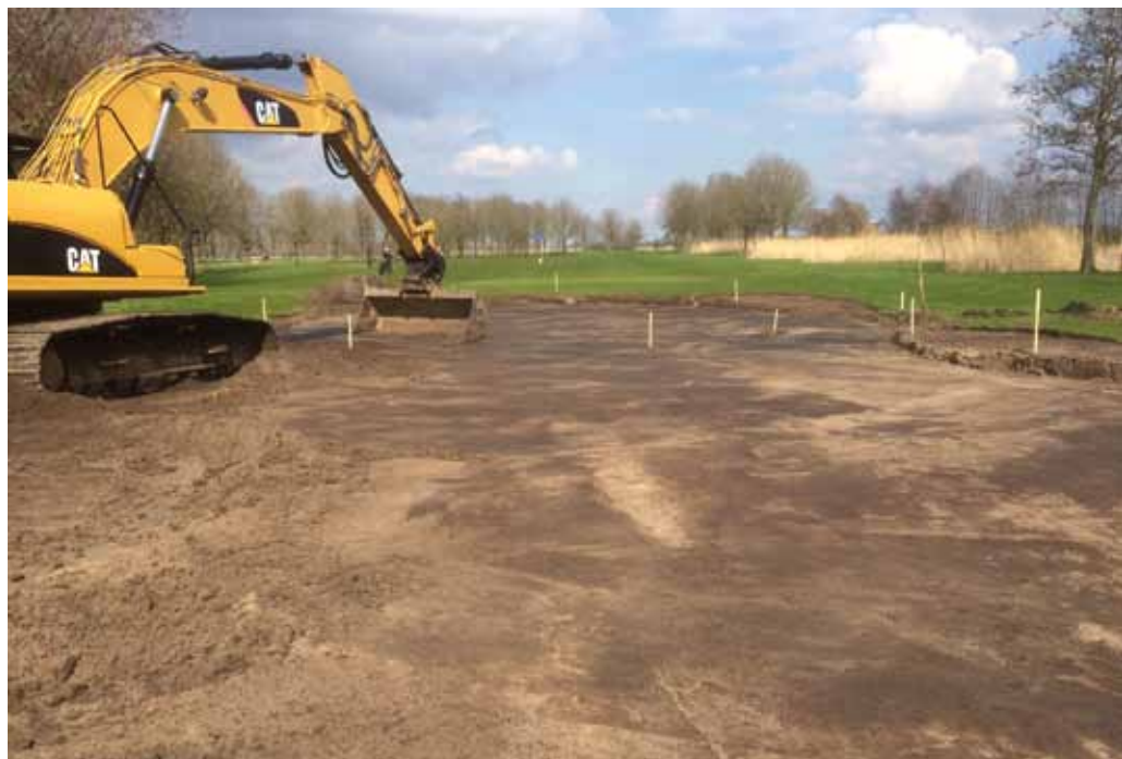
Renovatie Hitland SBA Groen en Golf
