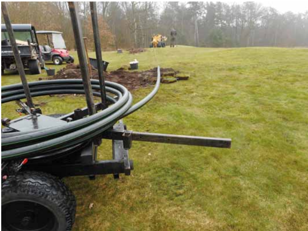
Na een bunkerrenovatie wordt nu de beregening aangepakt.
