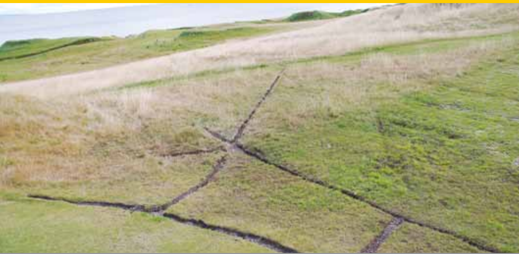
Een zogenaamde catchdrain, opvang van oppervlaktewater.
