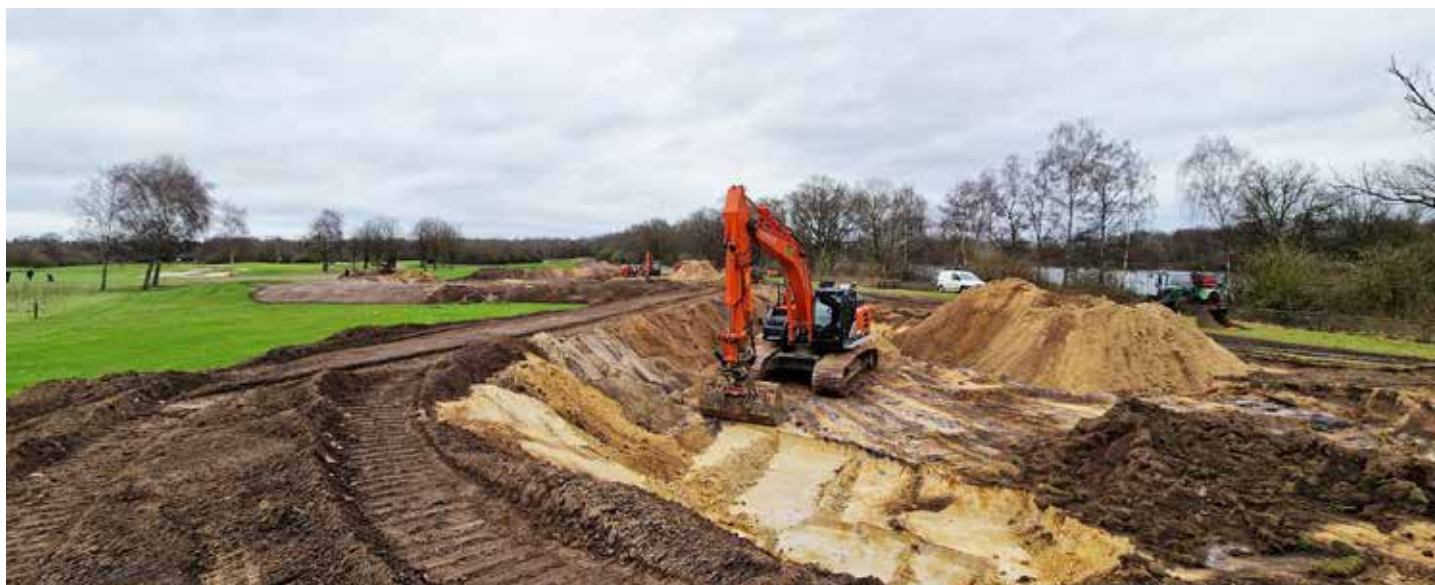
De graafwerkzaamheden startten in januari.
