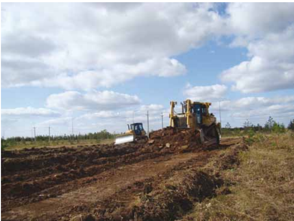
Het afstrippen van de toplaag; het makkelijkste onderdeel.
