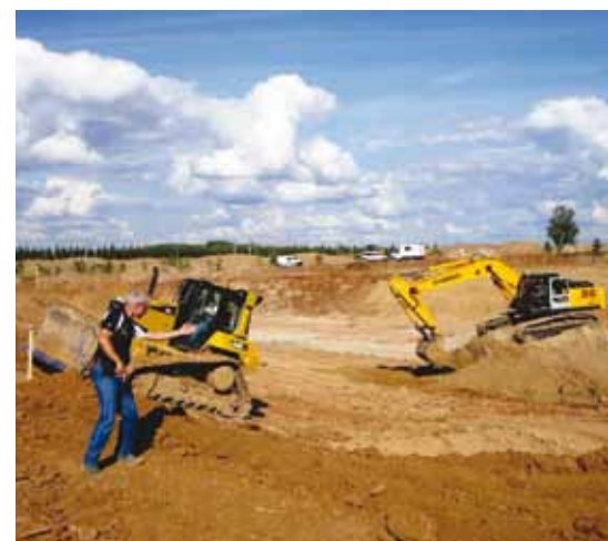
De aanleg van het irrigatiemeer, dat meer dan 100'000 m 3 water bevat.
