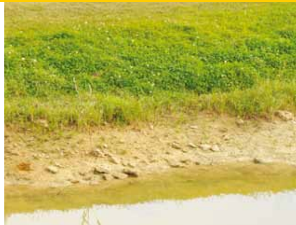
Beregeningswater wordt uit de vijvers gepompt. Het waterpeil daalt als gevolg daarvan. Daarom wordt op termijn een extra vijver gebouwd voor meer buffer.
